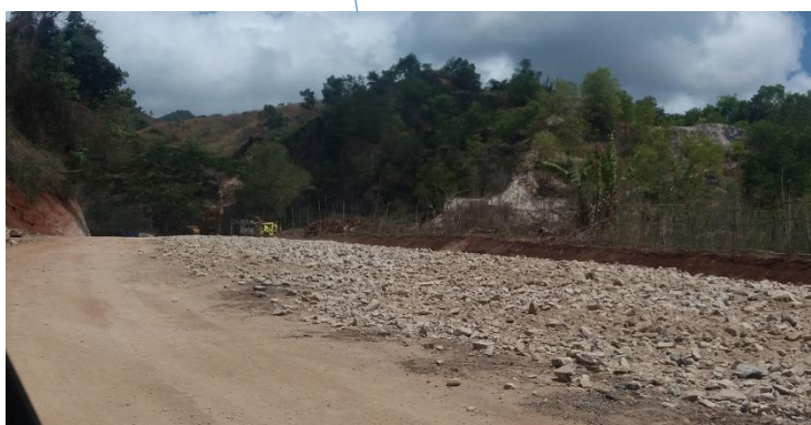
Zone d'activité (bris de roche) à l'entrée de la carrière à environ 250m
